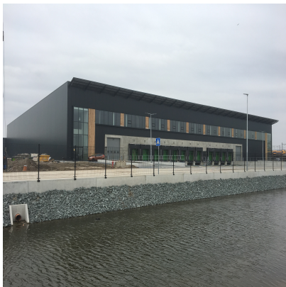
SEGRO Park Amsterdam Airport, gasloze energievoorziening
